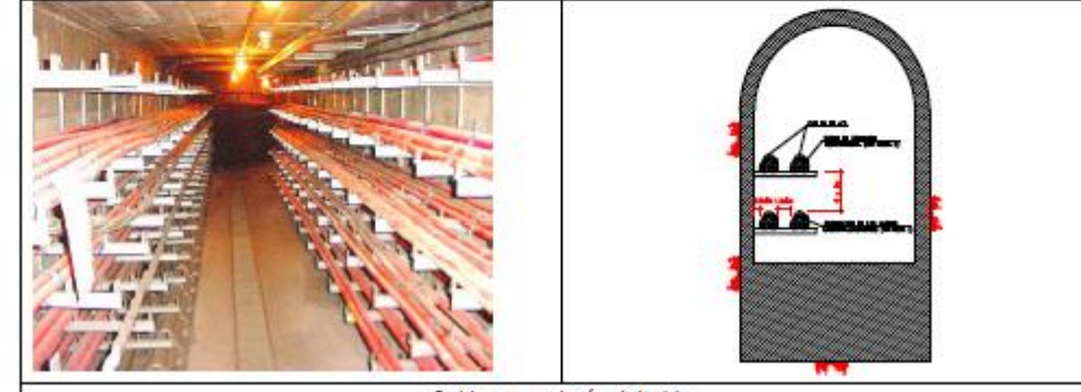
Cables en galería visitable
